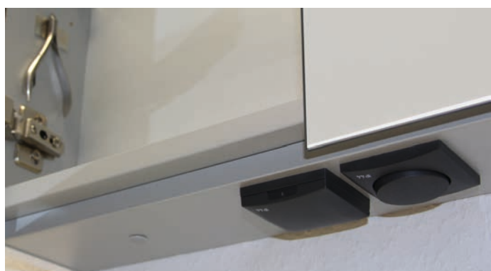
Detail umístění zásuvky a vypínače BERKER na spodní straně ZS
